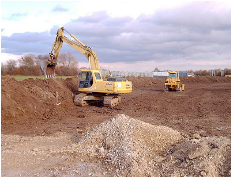
Der Bau der Südost-Umgehung hat im Herbst begonnen.
