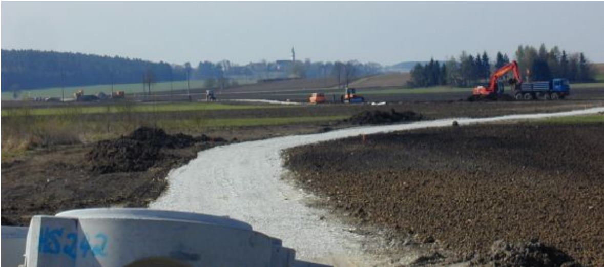
Bayerdilling war das Ziel des 2002 abgeschlossenen Kanal-Bauabschnitts; gebaut wurde entlang der Kleinen Paar.
