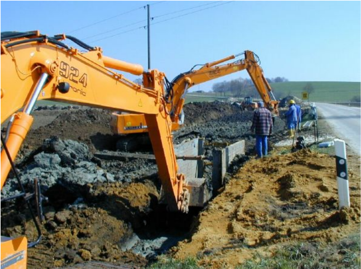
Kanalbau neben der Kreisstraße Sallach – Gemping.
