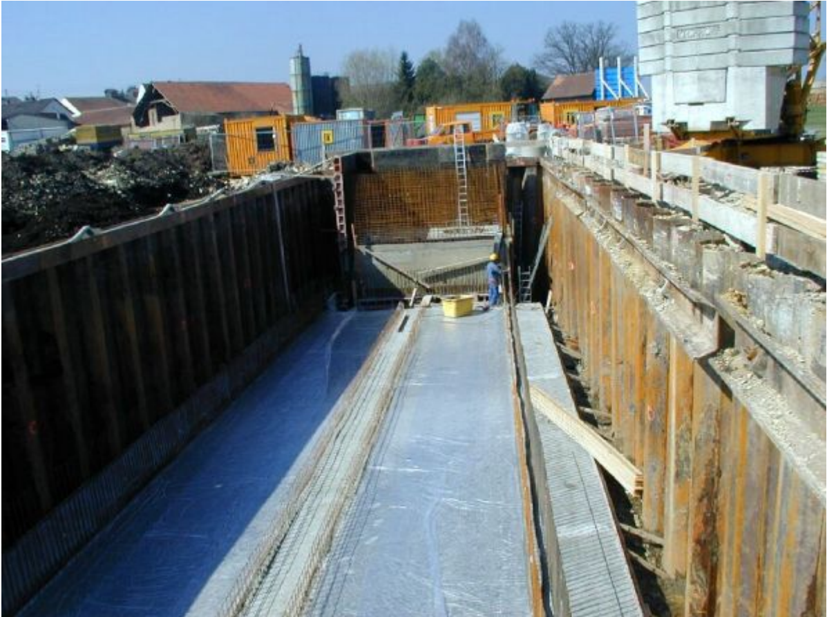
Herstellung der Bodenplatte beim Pumpwerk Überacker.
