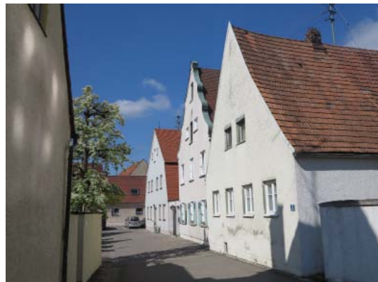
Schulgasse - Gebäude mit energetischem Sanierungsbedarf
