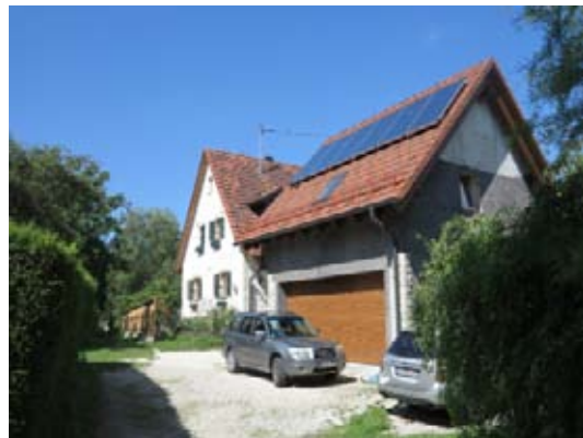
Beispiel für Solarenergieanlage
