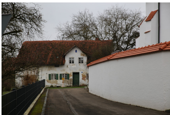
Abb. 30: Offenkundig leerstehende Hofstelle in Wallerdorf
