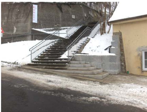
Straßensanierung Gempfung (oben)
