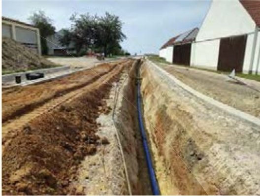
Rainer Straßl, Sallach Erneuerung der Wasserleitung im Zuge der Kanalsanierung
