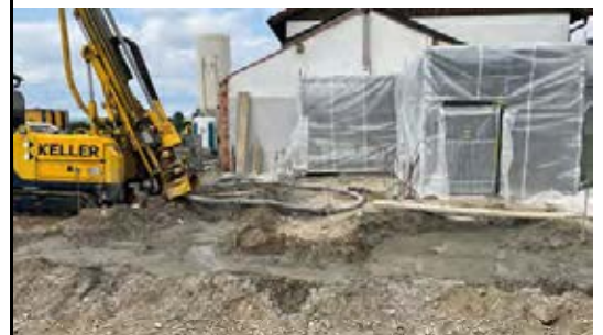
Einhausung der in Betrieb bleibenden Maschinentechnik
