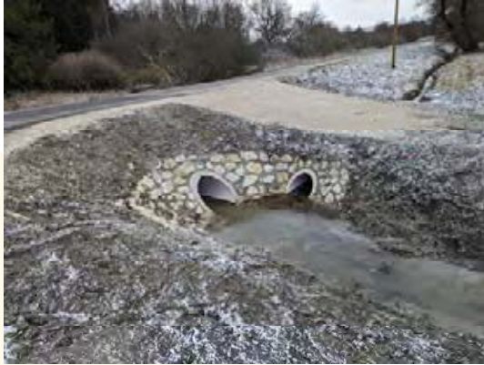
Erneuerung Durchlass Lüßkanal
