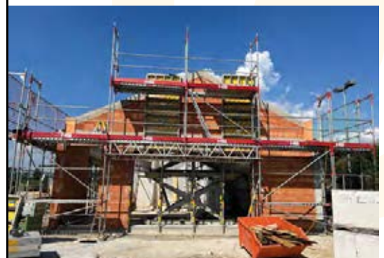
Rohbau neues Rechengebäude
