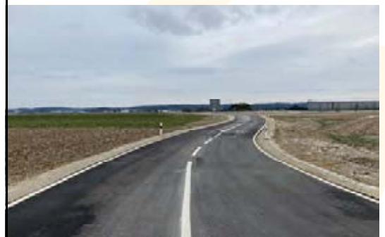
Erneuerung Gemeindeverbindungsstraße „Rainer Straßl“
