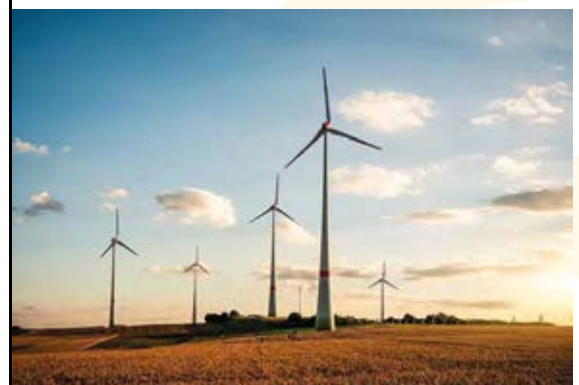
Beispiel einer Windparkanlage
