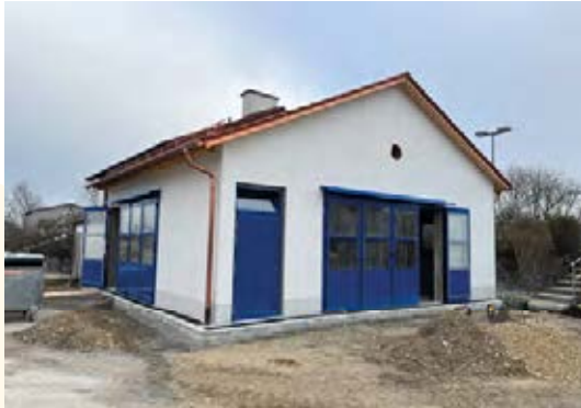
Neues Gebäude vor Fertigstellung
