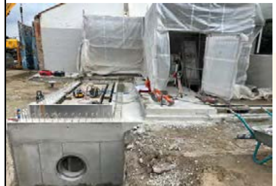
Herstellung neuer Pumpensumpf für die neuen Rechen
