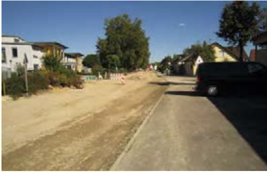
Erneuerung Gehweg , Wasser- und Kanalleitung
