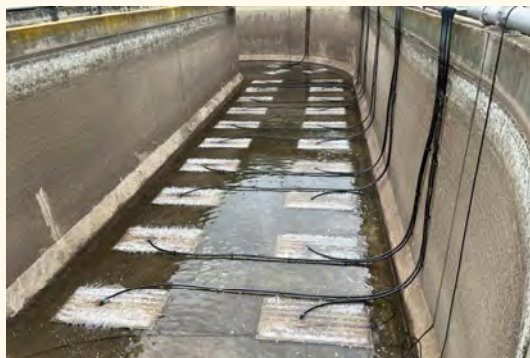
leeres Belebungsbecken ( V = \text{ca. } 2.400 \text{ m}^3 )
