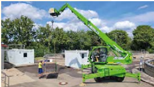
Ausbau der defekten Platten
