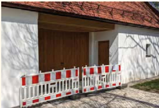
Sperrung der öffentlichen Toiletten im Nebengebäude Schloss
