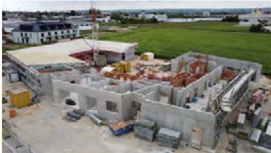
Rohbau der Kindertagesstätte
