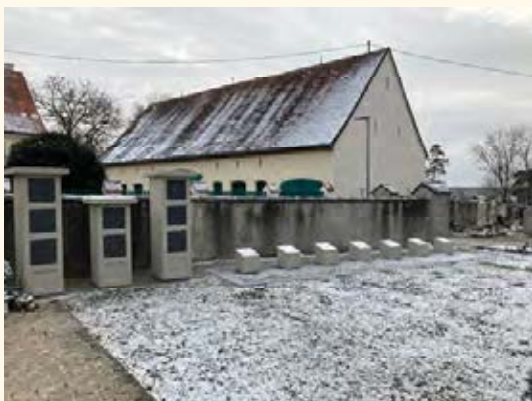
Erweiterung Urnenanlage Bayerdilling
