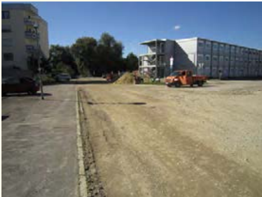
Erneuerung Gehweg , Wasser- und Kanalleitung
