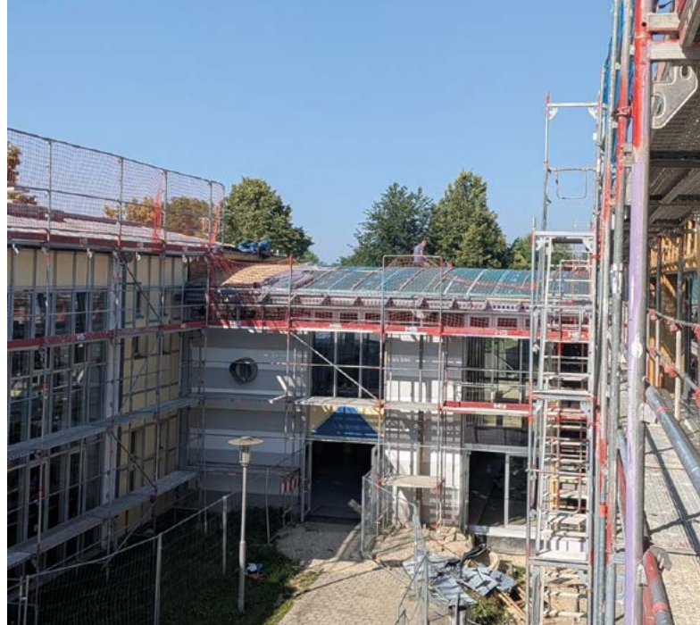
Verbindungsbereich zwischen Bestand und Neubau – die neue Pausenhalle.
