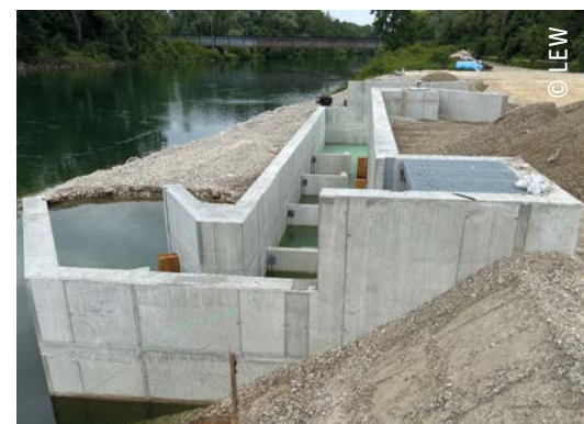
Die Fischaufstiegsanlage am Kraftwerk Rain nimmt zunehmend Gestalt an.
