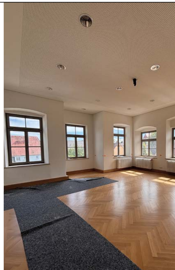
Die sanierten Räume im Westflügel füllen sich bald mit Leben.
