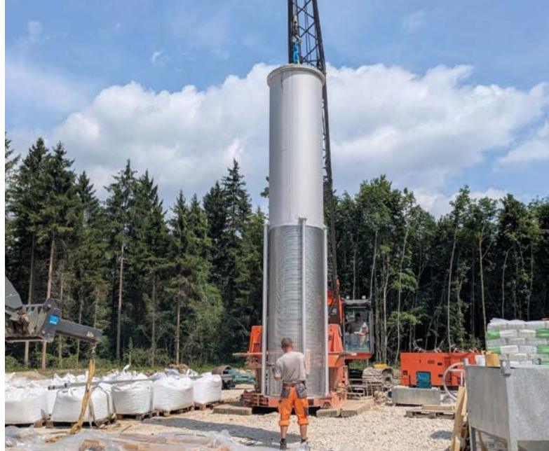
Die Bohrung für den neuen Brunnen VIII ist abgeschlossen. Er soll künftig die Trinkwasserversorgung im Stadtgebiet sichern.
