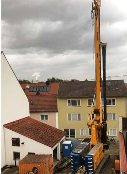
Mit einem riesigen Bohrgerät wurden Pfähle zur Absicherung der Baugrube gesetzt.
