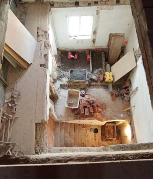
Durch den Abriss der alten Treppe und der Zwischendecken entstand ein Hohlraum über drei Etagen.
