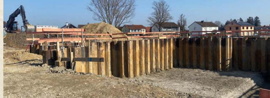
Tief in den Boden eingerammte Spundwände stabilisieren den Boden für den Kellerbau.
