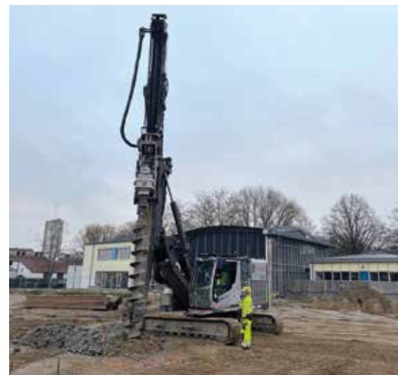
Bohrgerät zur Lockerung des Erdreichs für den Einbau der Spundwände
