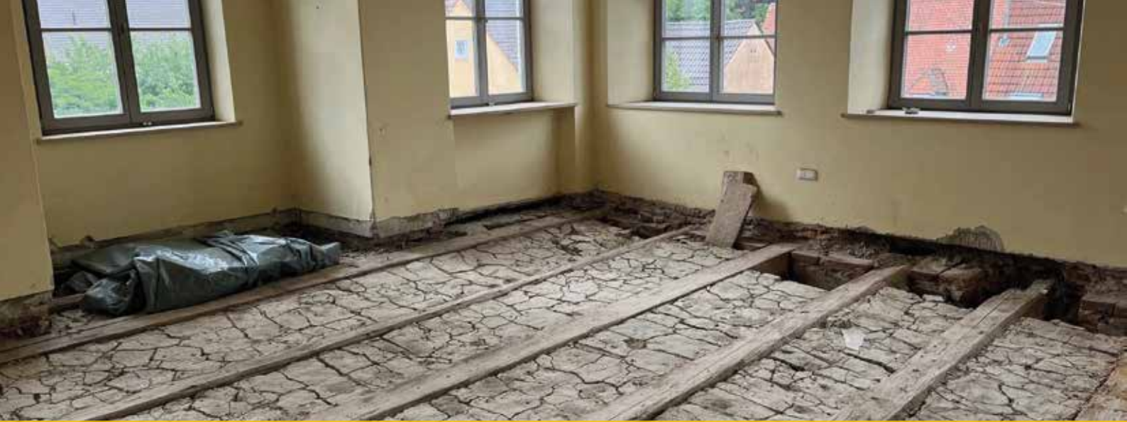
Bodenöffnung im Obergeschoss: Balken mit Lehmstakfüllung
