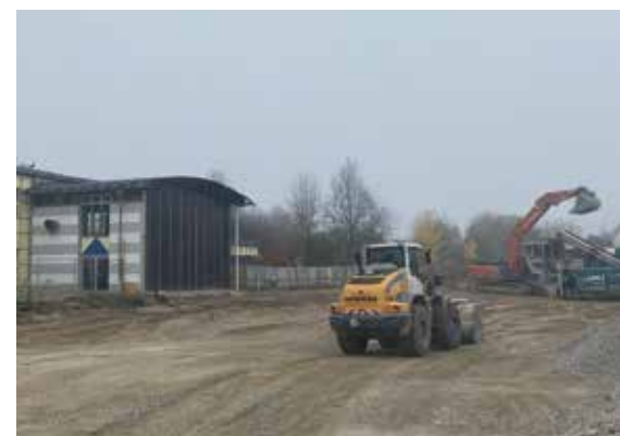
Abbrissarbeiten an der Grundschule Stand Oktober 2024
