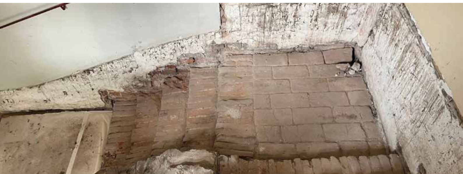
Gemauerte Schachttreppe, die unter der bestehenden Holzterrasse zum Vorschein kam
