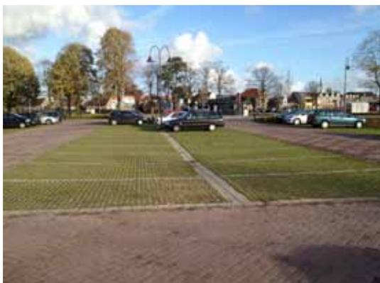
Abb. 30: Beispiel-Foto teilentsiegelter Parkplatz mit Rasengittersteinen zur Versickerung
