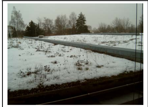
Bild 39: Dach über den Fachräumen
